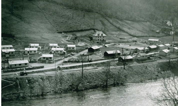
La cité éphémère et les barraquements en 1941. La cité en pierre est en cours de construction. On aperçoit déjà l'hôtel et juste à côté la chapelle Saint-André commence à sortir de terre. ©EDF
